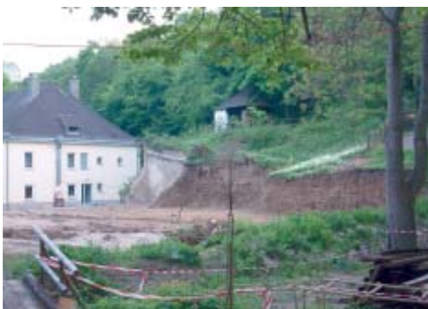
Fertig zum Baubeginn: Hier wird die neue Herberge stehen.
